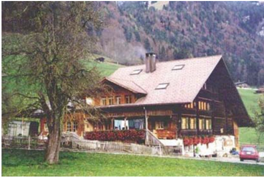
Fig. 12. Clásica construcción con tejado de alta pendiente para evitar hundimientos del techo por acumulación de nieve.
