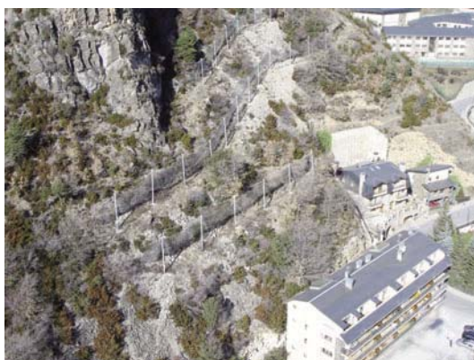
Fig. 22: Ejemplo de protección pasiva (barreras dinámicas) en Andorra la Vella. (Foto: Ramon Copons).
