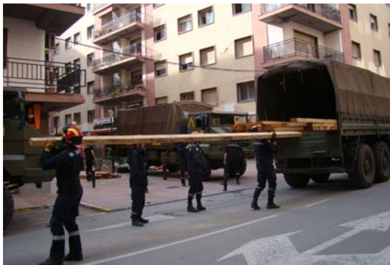
Fig. 4. La unidad militar de emergencia, los servicios de protección civil y los bomberos coordinaron las situaciones de emergencia. En la fotografía se observa a la UME en las labores de apuntalamiento de uno de los muchos edificios con amenaza de colapso.
