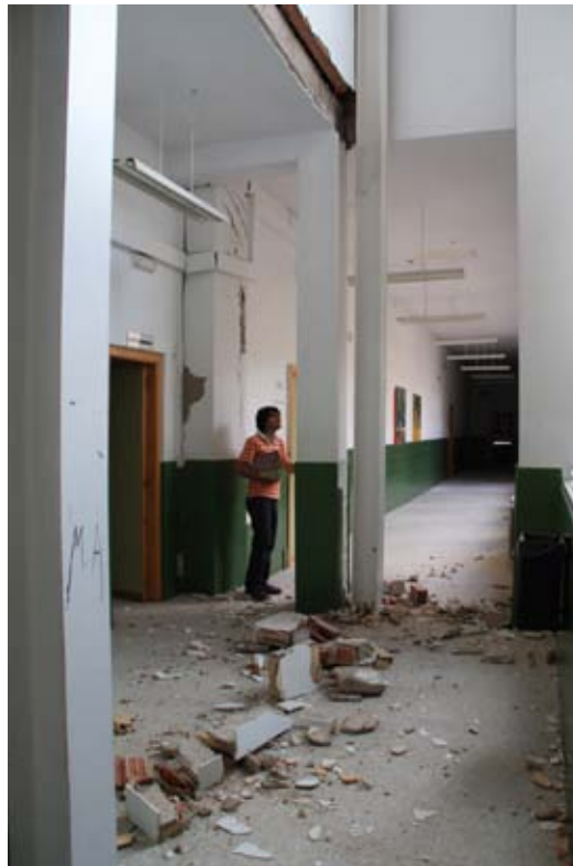
Fig 3. Daños producidos por el terremoto en el I.E.S. Ramón Arcas Meca de Lorca.
