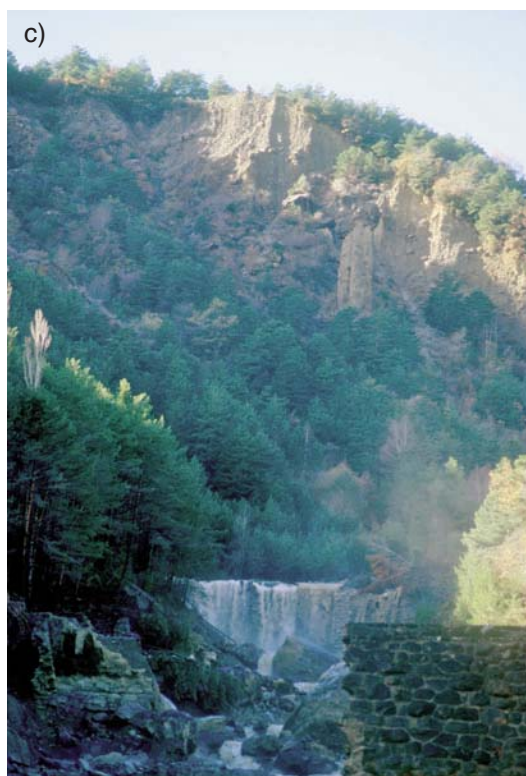
Fig. 11.-El abanico del barranco de Arás después de la avenida de 1996 (a) visto desde aguas abajo con el nuevo cono de derrubios depositado justo antes de alcanzar el camping; (b) detalle del frente del cono de derrubios acumulado y (c) una de las presas de contención dentro del barranco, ya rota y vaciada de sedimentos (observar las cicatrices erosivas existentes sobre las morrenas al fondo que indican la continuidad en la actividad de los procesos).
